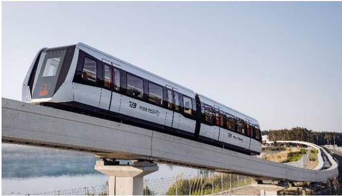
TSB Train à Sustentation Magnétique sur un parcours test
