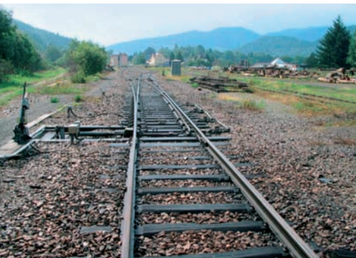
● appareil de voie et traverses dans la vallée de la Thur (Mulhouse-Kruth)
