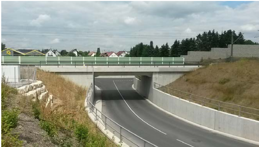
Kreuzungsbauwerk EÜ Gemeindestraße als Vollrahmen
