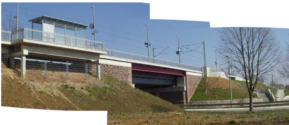
EÜ Renninger Straße, Bahnsteigbrücke, Bahnsteig 2
