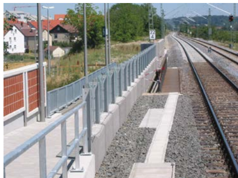
östlicher Zugang zum Bahnsteig 1; LSW
