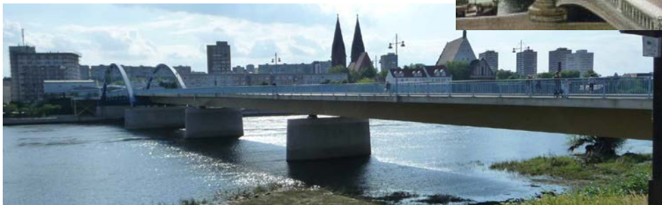
Erneuerte Stadtbrücke über die Oder (oben links alte Brücke vor 1944)
