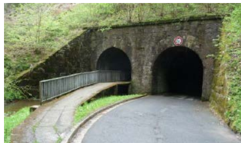
Eisenbahnüberführung bei Tremersdorf
