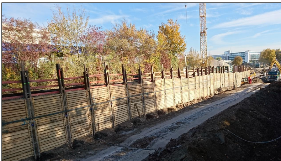
Realisierung der Tieferlegung der Herrenberger Straße in Böblingen
