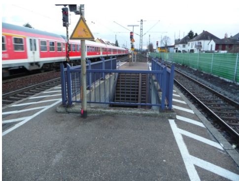
Bahnhof Blankenloch: Zugang Mittelbahnsteig (Bestand)
